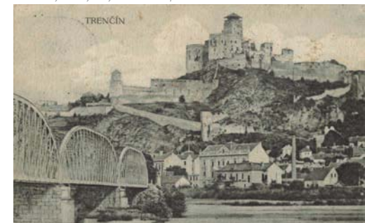
Pôvodný železničný most postavený v roku 1883.
