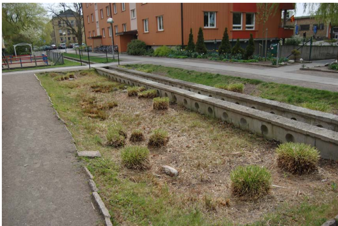
Foto 5: Systém vsaku dažďovej vody v terénnej depresii a zároveň jej odvodu v prípade príliš intenzívnych zrážok Augustenborg, Švédsko (archív autorky)
