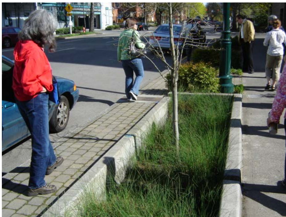
Foto 7: Bioretenčné systémy ako súčasť menežmentu dažďovej vody v uliciach, Portland, USA (foto Anna Hochhalter)
