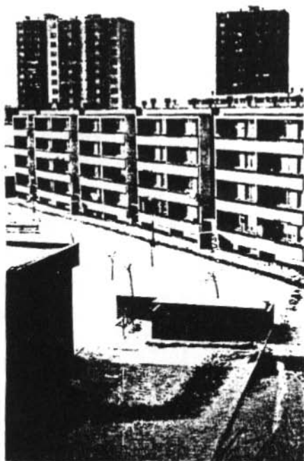
Obr. 10. Slnečná loggia vytvára v KBV vítaný „súkromný“ exteriérový priestor bytu a voči oknám preberá funkciu mrežového sťolamu a veternej ochrany. Na zasneženom teréne sídliska v blízkosti kotolne ľahko zbadáme zbytočné tepelné straty teplovodných rozvodov.
