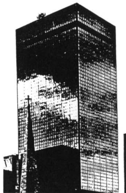
Obr. 11. Skoro úplné zasklenie fasád nemá racionálne opodstatnenie a zbytočne spôsobuje nepriaznivé podmienky na zabezpečovanie pohody interiérového prostredia okrem energetickej a ekonomickej nevýhodnosti.
