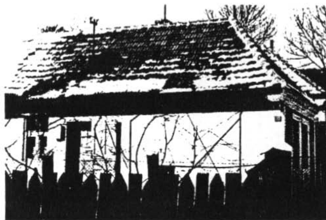
Obr. 7. V domorodej a ľudovej architektúre sa často využíval tieniaci účinok južne orientovaného prístrešku alebo „ganku“, ktorý v lete pri vysokých slnečných lúčoch zatienoval okná, kým v zime dovoľoval nezníženú insoláciu interiérov. Tento princíp aplikuje v KBV južne orientovaná loggia.
