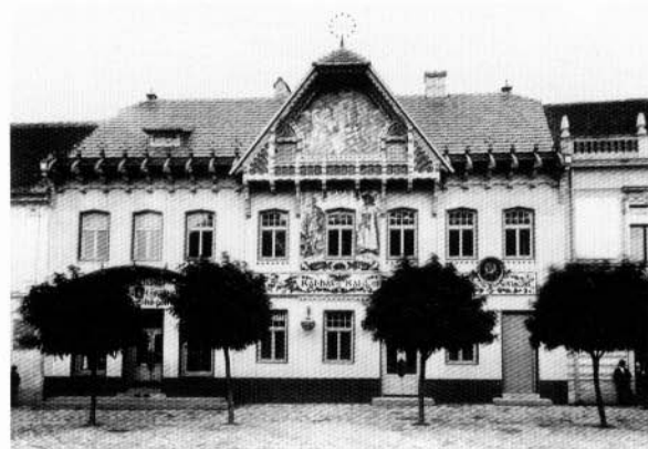
Průčelí Spolkového domu ve Skalici. (SNA)
