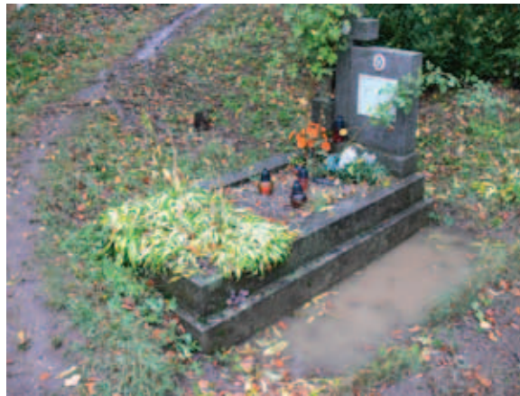
Obr. 13 Voda nahromadená v blízkosti hrobov ohrozuje fyzickú podstatu a stabilitu hrobových obručníkov i náhrobníkov. (Foto E. Kráľová)
