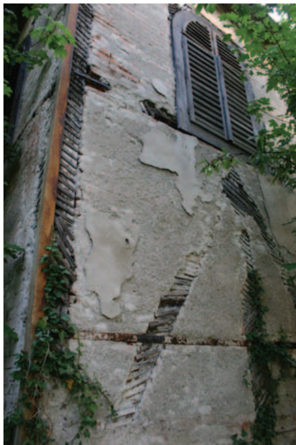
Obr. 9 Omietaný povrch stien na náveternej SZ strane objektu fyzicky je natoľko degradovaný, že umožňuje „prečítať“ konštrukčnú schému a priebeh nosných prvkov. (Foto E. Kráľová)
