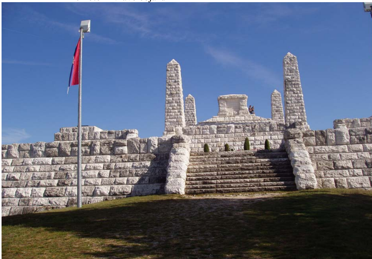
2.-- obr.012 – mohyla – čelný pohľad od západu
