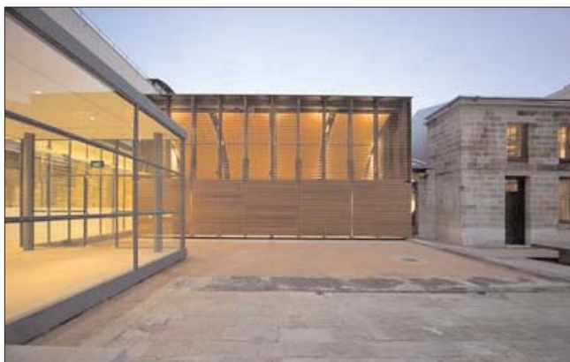
Areál bývalej mincovne v Sydney - dostavba areálu. The Mint. Sydney. 2004.
