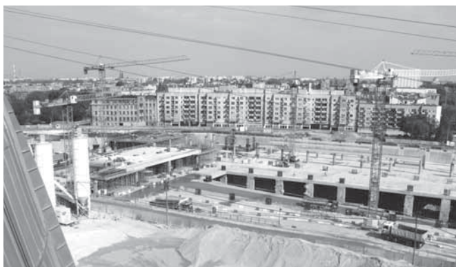
Rozostavaná spodná stavba novej železničnej stanice „Lodź Fabryczna“.
