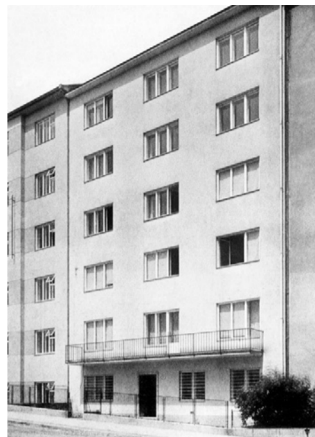
3 Nájomný dom Brno-Veveří
