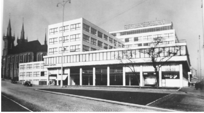
Budova Elektrických podnikov v Prahe a interiér haly
