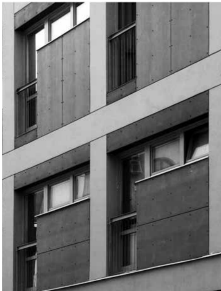
Detail fasády. Zdroj: Projekt, roč. XLVIII, č. 6/441/2006
