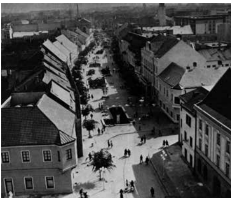
Celkový pohľad na pešiu zónu - Hlavnú ulicu (bývalú ulicu Februárového víťazstva). Zdroj: Projekt, roč. XXXXI, 1/323/1989, s. 12.
