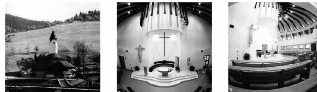
Exteriérový pohľad na kostol na úpätí svahu; jadro obradného priestoru. Zdroj: Projekt. Roč. XL, č. 1/1998, s. 24 – 25.
