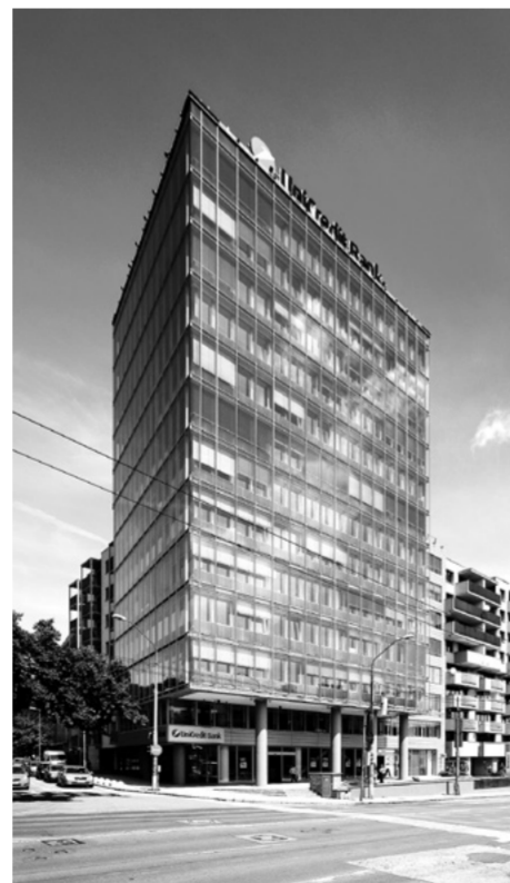
Realizácia polyfunkčných objektov D, E, F, Šancová ulica a Únicredit, Bratislava, Autori: Ivan Gürtler, Juraj Karásek, 1998-2002
