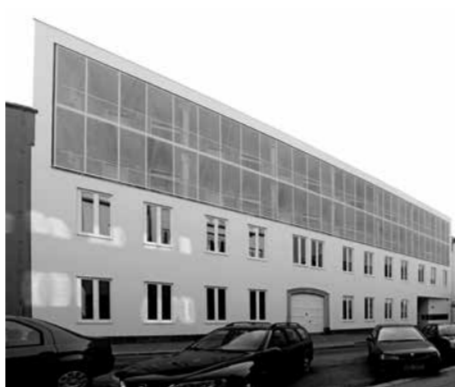
agg architekti, Rekonstrukce bytového domu v Brne, foto © agg architekti
