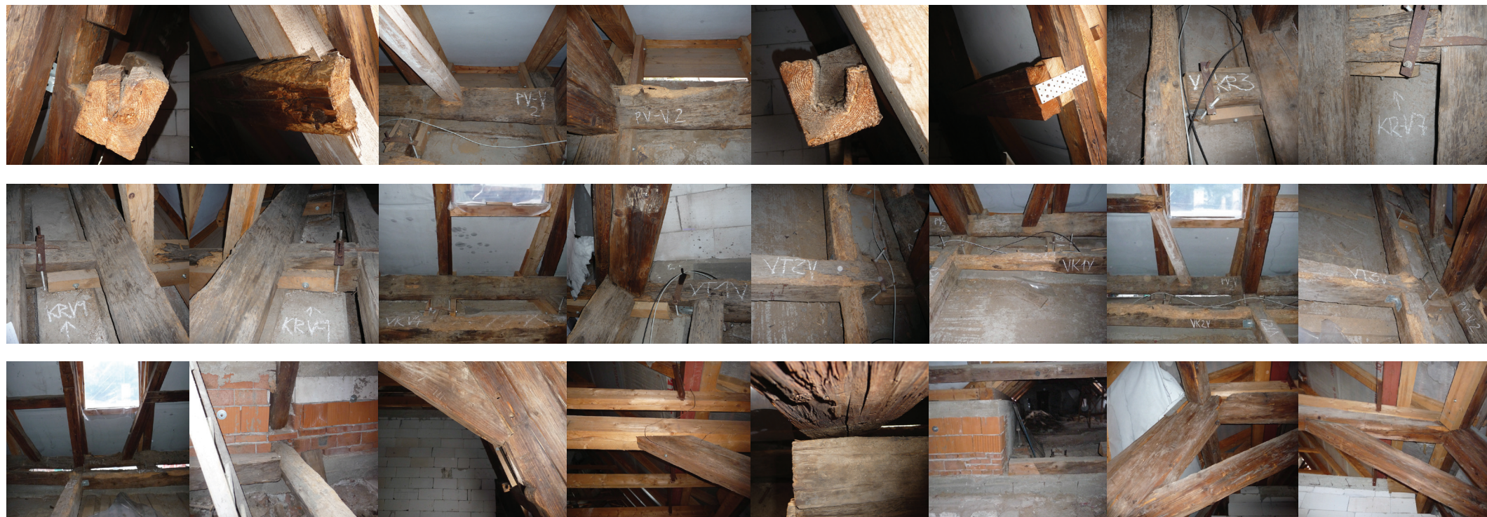
POZDĹŽNE VIAZANIE LEŽATEJ STOLICE-VÝCHODNÁ STRANA ... Longitudinal bracing - East
