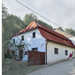
G POD ČERVENOU STUDŇOU 1
