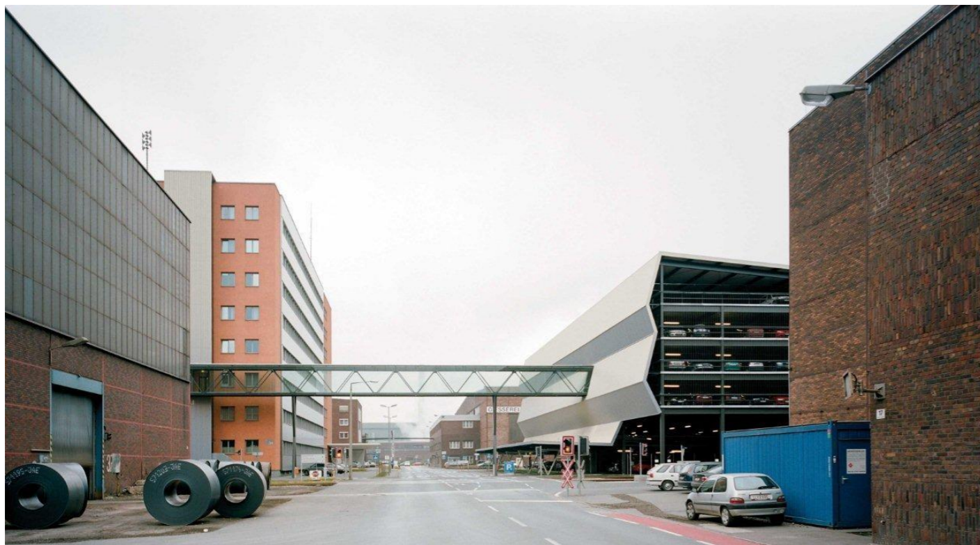
MULTI LEVEL PARKING VOESTALPINE. LINZ, RAKÚSKO. AUTOR: X ARCHITEKTEN
