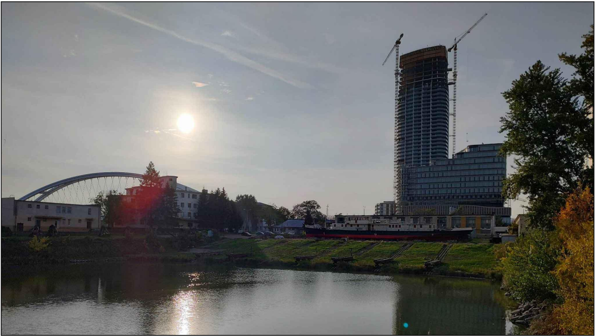
POHĽAD NA NKP LODNÝ VÝŤAH
