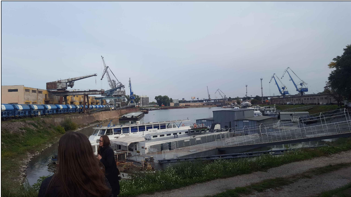
POHĽAD NA PRÍSTAVNÝ MOST
