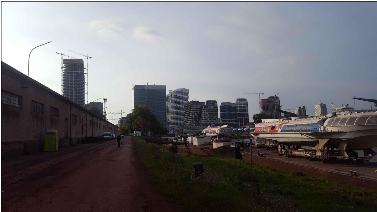
POHĽAD NA NOVOVZNIKNUTÝ DOWNTOWN
