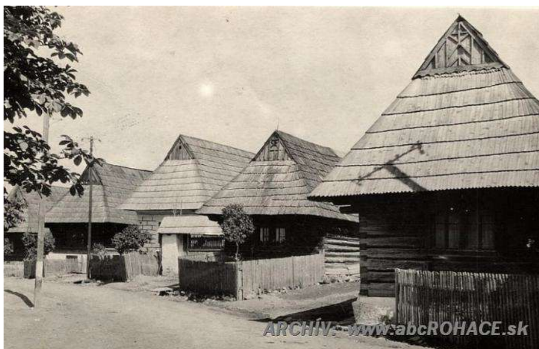
Úzke dlhé domy, orientované štítom do ulice. Domy boli tvorené z drevených brvien na kamennom základe, s bielym vápenným náterom. Strecha s vysokou podlomenicou, ktorá je obohatená polvalbou, krytina sa skladala z dreveného šindelu.
