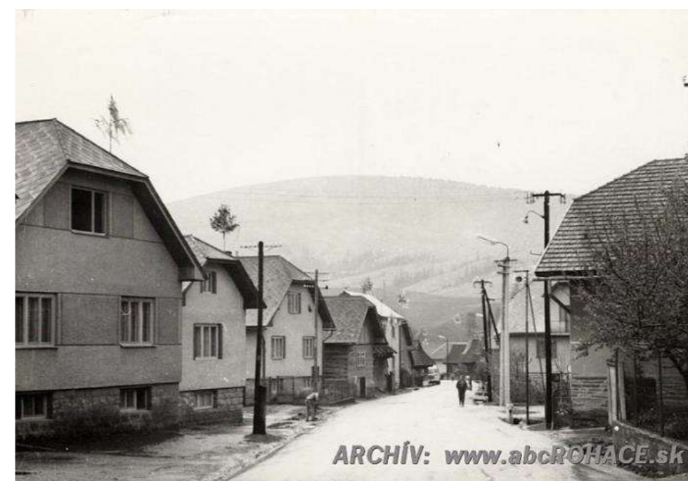
Murované objekty umožnili zvýšiť podlažnosť domov. Fasády sú zaomietané a drevený šindel na polvalbovej streche s podlomenicou nahradila polvalbová strecha bez podlomenice, s krycou vrstvou eternitu.
