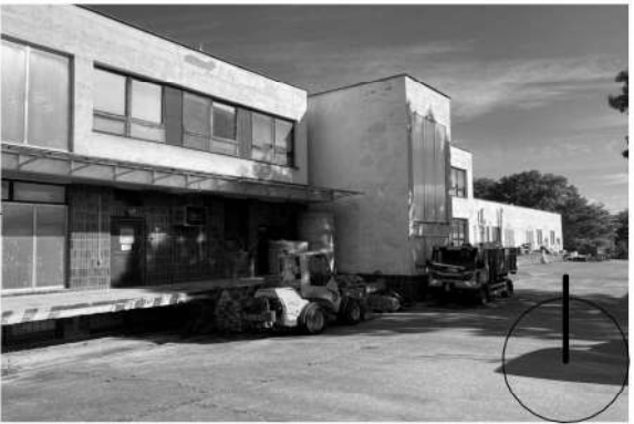
bývalé kasárne - zásobovanie
