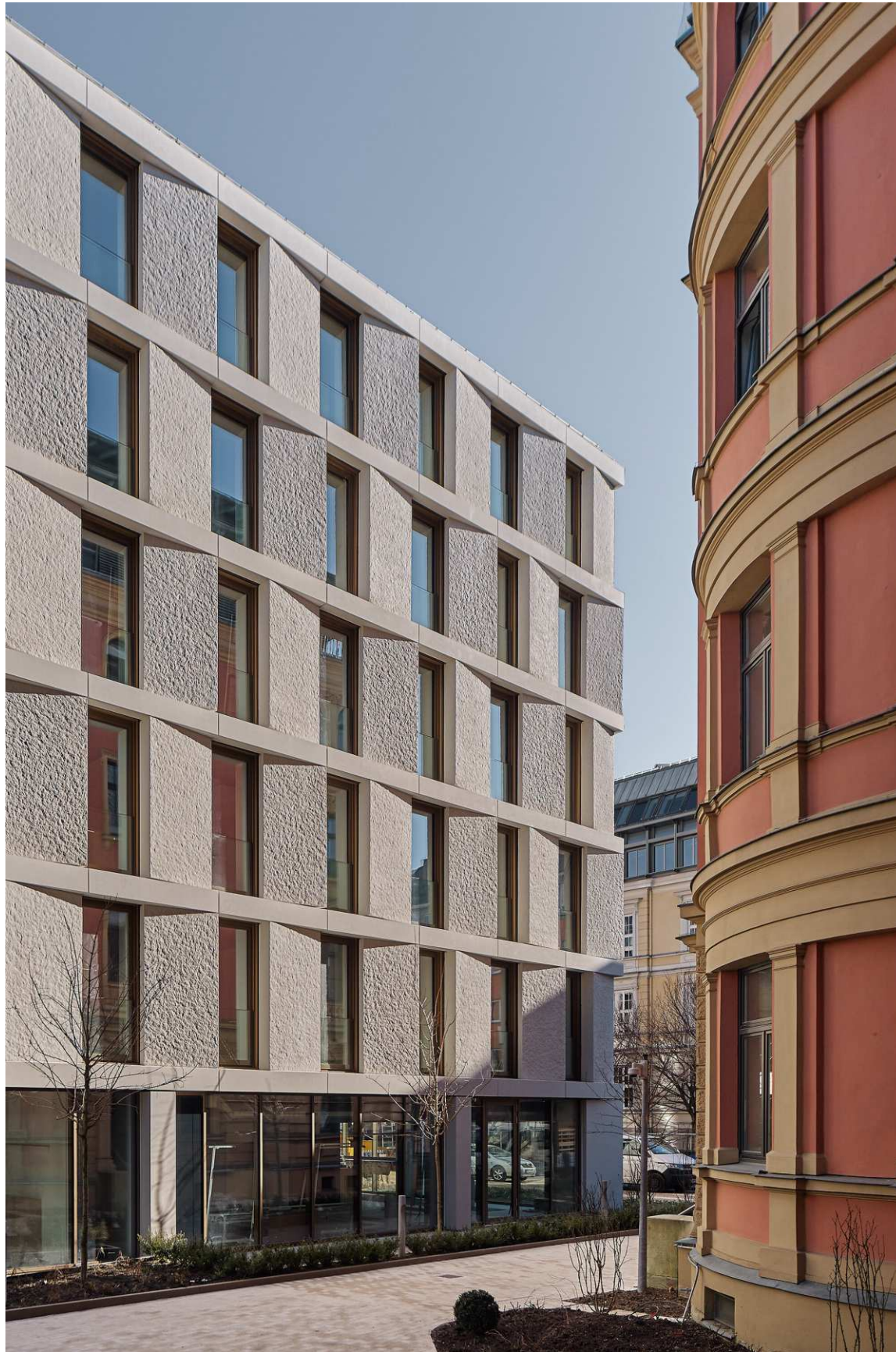
Das max, SCOPE Architekten GmbH, Nemecko, 2023
