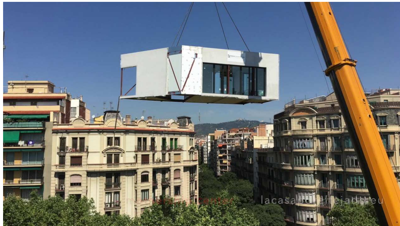
fotografia z osadzovania modulárnej prefabrikovanej drevenej nadstavby na historickú budovu v Barcelone v rámci projektu „La casa por el Tejado“ https://www.youtube.com/watch?v=jKIITiEX7Qo
