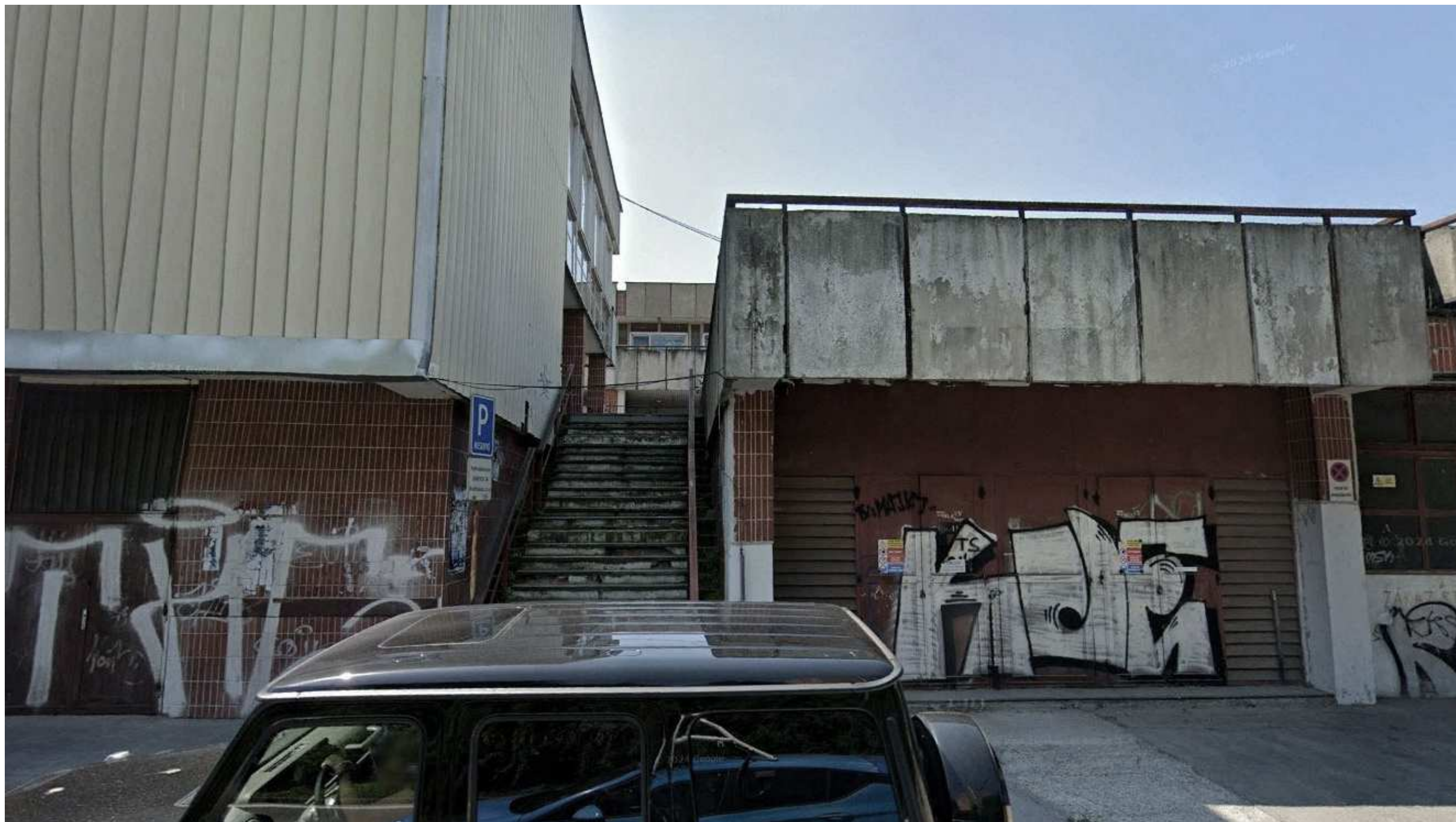
– pohľad na zásobovaciu fasádu budovy B a technickú prístavbu z ulice Obchodná – súčasný stav
