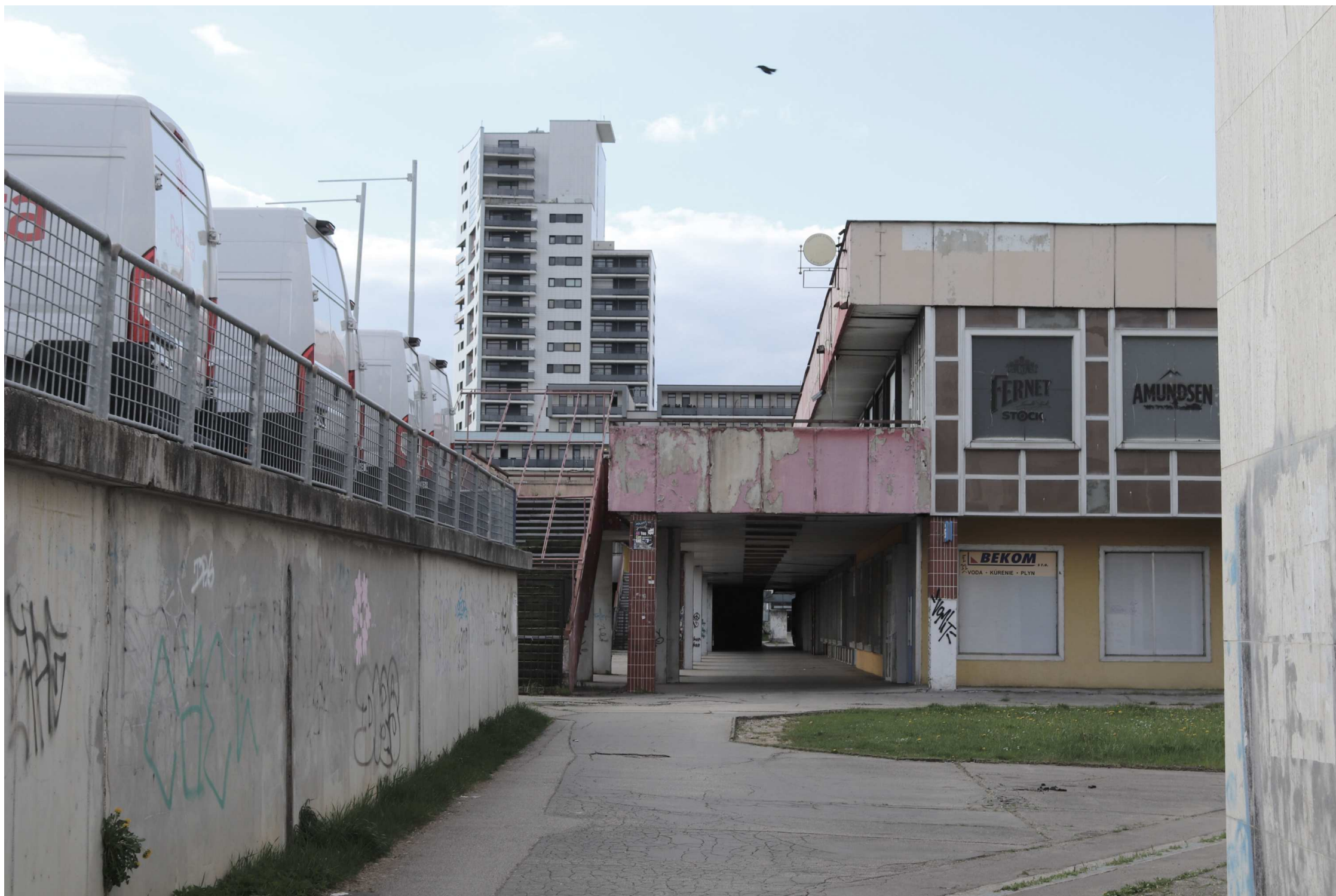
- vstup do existujúcej obchodnej pasáže
