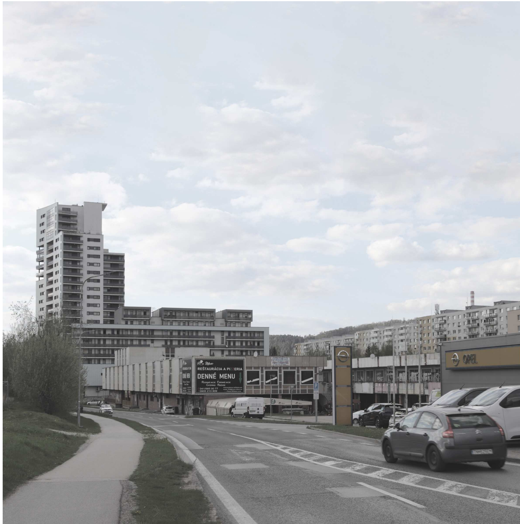
– pohľad na riešené objekty z ulice Vysokoškolákov
