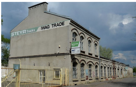
Snímky starej továrenskej budovy v zóne A
