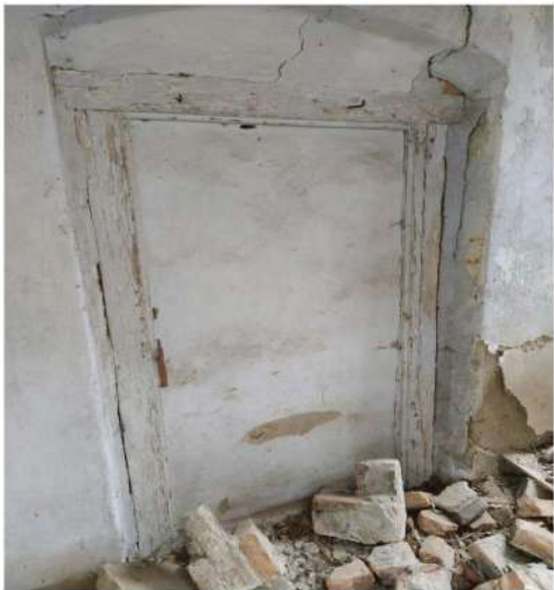
Zamurovaný dverný otvor (m.č. 1.18)
