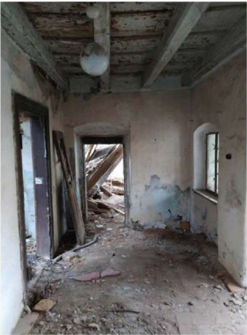
Zavlnhnutý trámový strop (m.č. 1.15)
