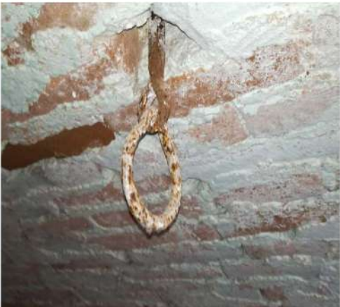
Kovový kruh osadený na oko visiace z muriva klenby pivnice -prvok je napadnutý hrdzou (m.č. 1.04)
