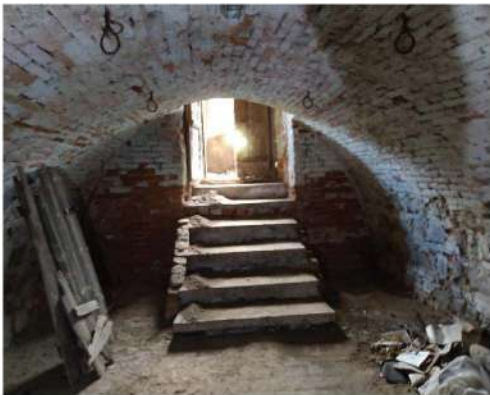
pivnica (1.PP) dvorového krídla (m.č. 01.04) – schodisko vedúce z exteriéru
