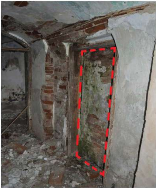
Zamurovaný dverný otvor v spojovacom krčku (m.č. 1.12)
