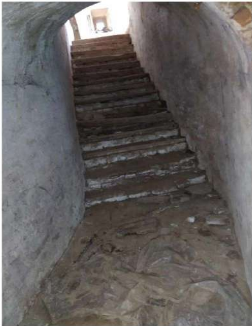
Valená klenba vstupnej chodby do suterénu uličného krídla (sekundárne farebné nátery)
