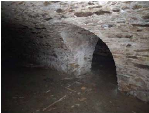
Zaklenutie miestností suterénu - výseče vstupných otvorov (stena medzi m.č. 1.02 a 1.03)
