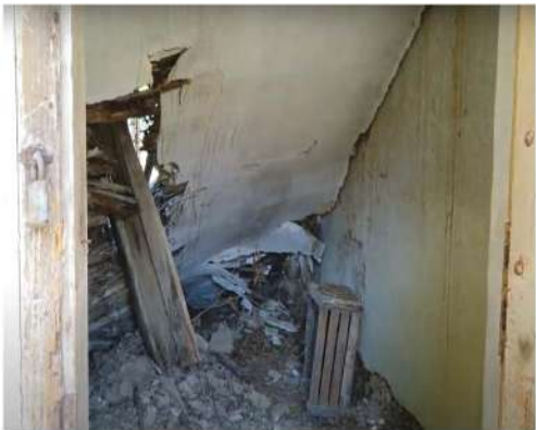
Prepadnutý trámový strop (m.č. 1.17)
