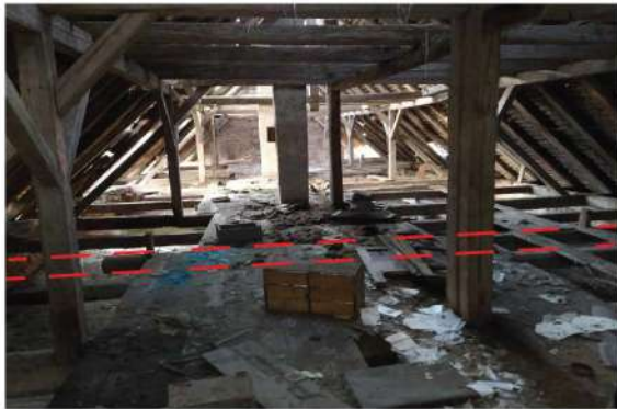
Uličné krídlo- poškodené väzné trámy vlhkosťou
