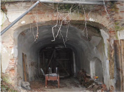
Sekundárne farebné nátery, lokálne úbytky pôvodnej hmoty (m.č. 1.01)
