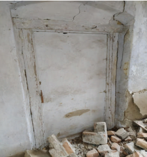
Zamurovaný dverný otvor (m.č. 1.18)
