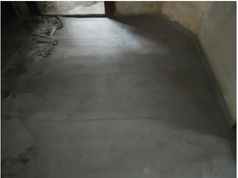
Lokálne úbytky pôvodnej drevenej palubovej podlahy (m.č. 1.07)
