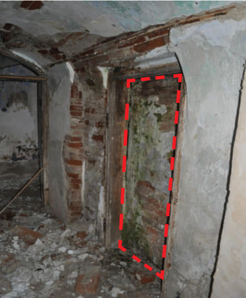
Zamurovaný dverný otvor v spojovacom krčku (m.č. 1.12)
