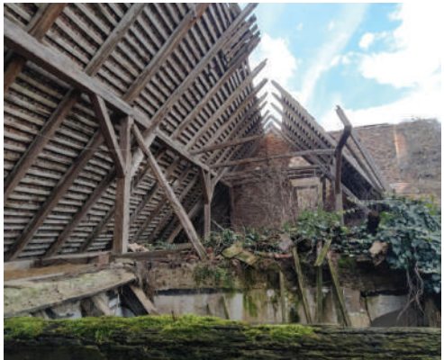
Dvorové krídlo- krov je vystavený poveternostným podmienkam
