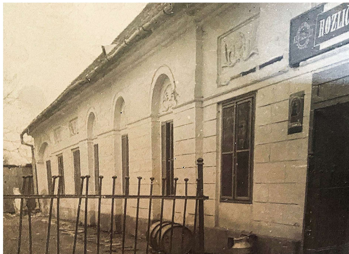
3 Fotografia znázorňuje už fungujúcu prevádzku potravín Jednota (polovica 20. storočia)
