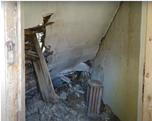
Prepadnutý trámový strop (m.č. 1.17)
