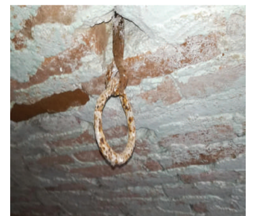
Kovový kruh osadený na oko visiace z muriva klenby pivnice -prvok je napadnutý hrdzou (m.č. 1.04)
