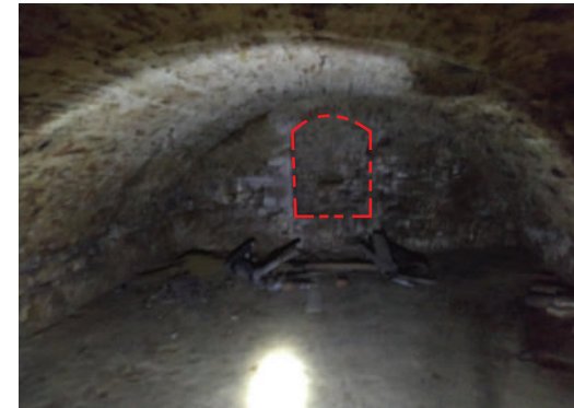
pivnica (1.PP) uličného krídla so zapustenou nikou (m.č. 01.03)
