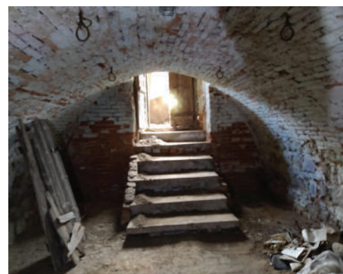
pivnica (1.PP) dvorového krídla (m.č. 01.04) - schodisko vedúce z exteriéru
