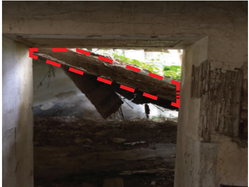
Prepadnutý trámový strop v dôsledku uhnitia záhlaví trámov (m.č. 1.13)
