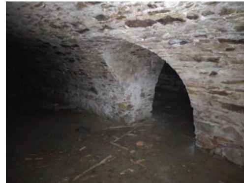
Zaklenutie miestností suterénu - výseče vstupných otvorov (stena medzi m.č. 1.02 a 1.03)
