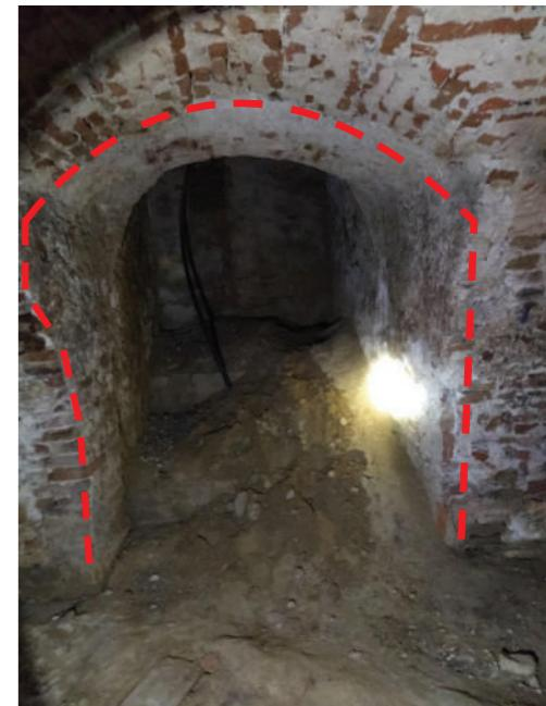
Valená klenba zaniknutého vstupu do pivnice lokálne úbytky pôvodnej omietkovej hmoty (m.č. 1.02)
