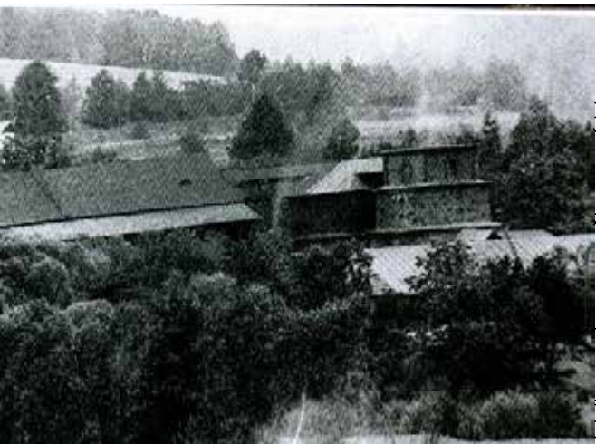
detail s vysokou pecou ešte v prevádzke
