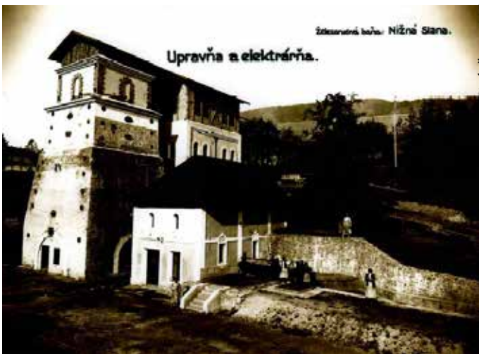
vysoká pec s novou upravovnou a elektrárnou, 1907
