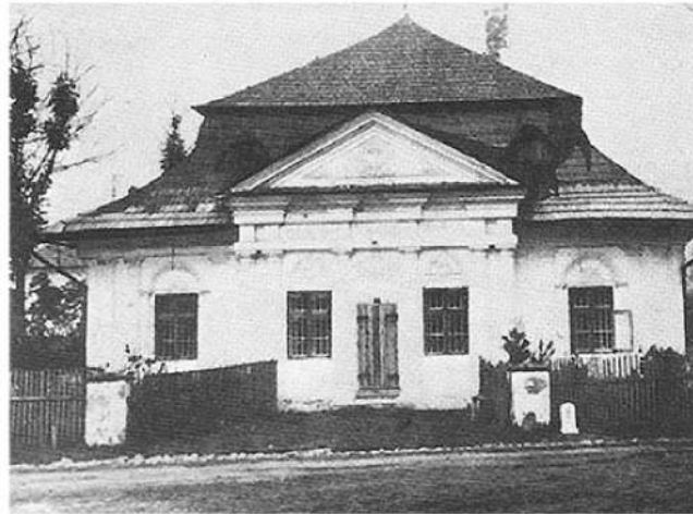
Murovaný dom s rokokovo-biedemeierovskou fasádou a štruktúrovou ozdobou, zač. 19. st.
