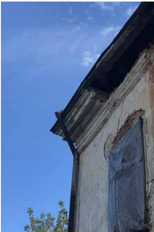
3NP_ FRAGMENTY MUROVANEJ RÍMSY [autorská fotografia]
