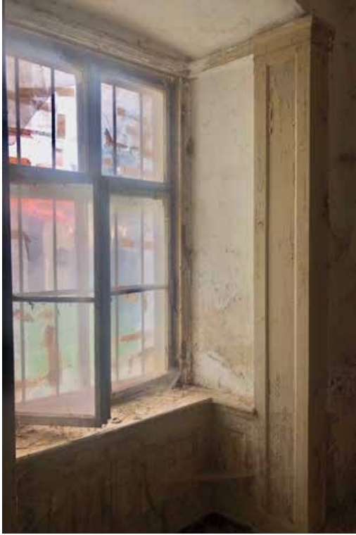
1NP_ OKENNÉ OTVORY S KAZETOVÝM OBLOŽENÍM [autorská fotografia]
