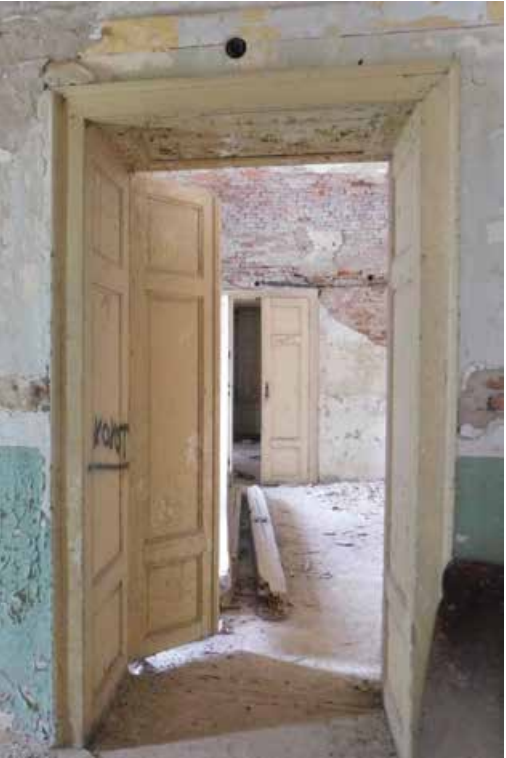
2NP_ DREVENÉ OBLOŽKOVÉ ZÁRUBNE A DVERE S KAZETOVÝM MOTÍVOM [autor: Jakub Svrbík]
