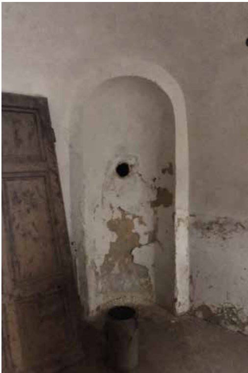
1NP_ ROŽNÉ VÝKLENKY PRE VYKUROVACIE TELESÁ [autorská fotografia]
