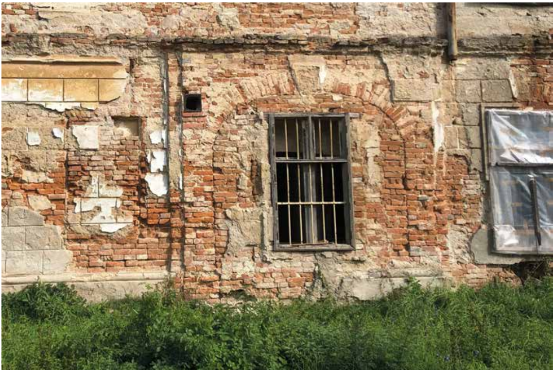
1NP_ VIDITEĽNÉ STARŠIE STAVEBNÉ ETAPY- ZAMUROVANÝ BAROKOVÝ PREJAZD OBJEKTOM [autorská fotografia]
