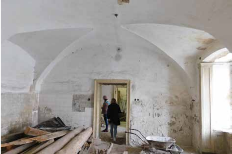
1NP_ VALENÉ KLENBY S 5-BOKÝMI LUNETAMI [autor: Jakub Svrbík]
