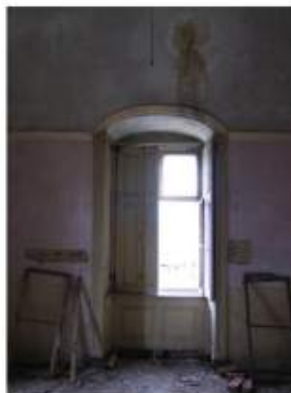
RÍMSA S DREVENÝM VYLOŽENÍM OKENNÉJ NIKI (2.NP)
