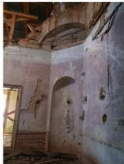
NIKI AKO POZOSTATOK PO KRBOVÝCH VLOŽKÁCH (2.NP)
