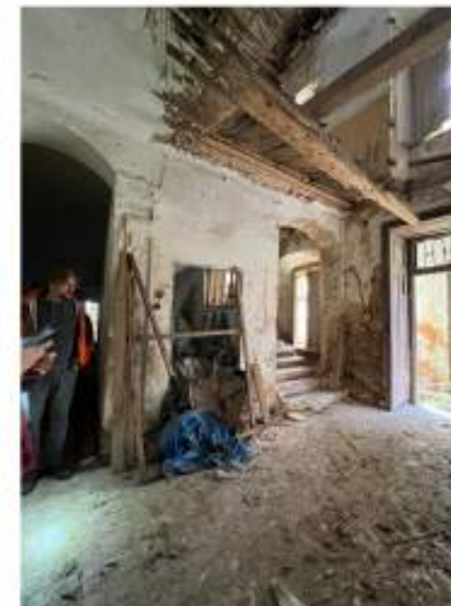
POHĽAD NA VSTUPNÉ PRIESTORY (1.NP)
