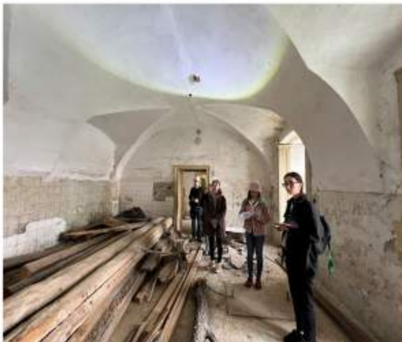
VALENÁ KLENBA S PAŤBOKÝMI VSTYČNÝMI LUNETAMI (1.NP)
