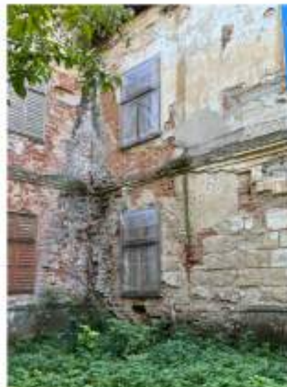
ZAMUROVANÝ BAROKOVÝ POVODNÝ PORTÁL (SEVERNÝ POHLED)
