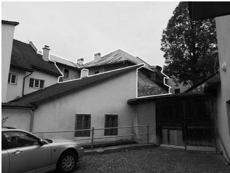
SÚČASNÝ EXTERIÉROVÝ OBRAZ OBJEKTU Z POHLADU CHODCA
