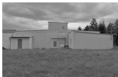
11. PRÍSTAVBA K VÝROBNEJ HALE - KANCELÁRIA Murovaná stavba 2. polovica 20. stor. bez viditeľného poškodenia. Možné odstránenie prístavby.
