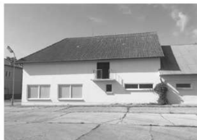
18. ADMINISTRATÍVA Murovaný objekt 1. polovica 20. stor. Bez hodnotných prvkov. Možné zachovanie objektu s nutnými úpravami.
