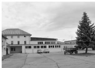
16. PRÍSTAVBA K VÝROBNEJ HALE Murovaný objekt 2. polovica 20. stor. Nevhodné doplnenie k existujúcemu objektu. Možné zachovanie objektu.
