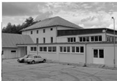
16. SÚKĚŇA Murovaná stavba 1. polovica 19. stor. Poškodenie objektu nánosmi z novších období. Nutné zachovanie objektu.
