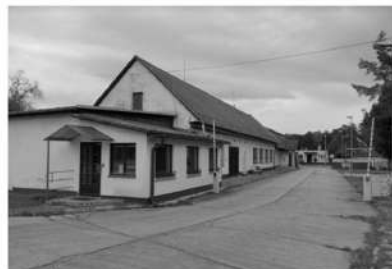
3. VRÁTNICA Murovaná stavba 2. polovica 20. stor., bez viditeľného poškodenia. Prístavba ku skladu.
