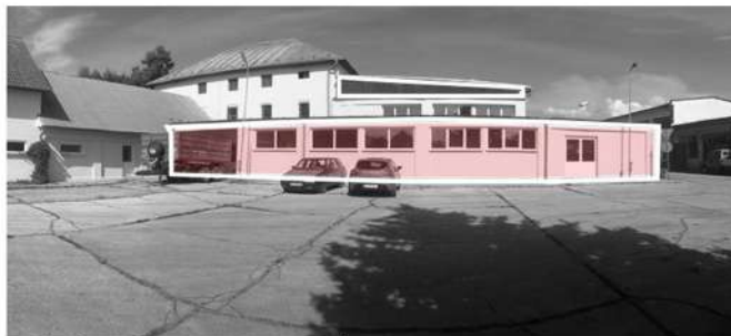
ODSTÁNENIE NEVHODNEJ PRÍSTAVBY
