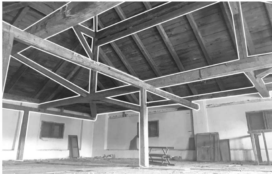
DREVENÝ KROV V HISTORICKEJ ČASTI BUDOVY
