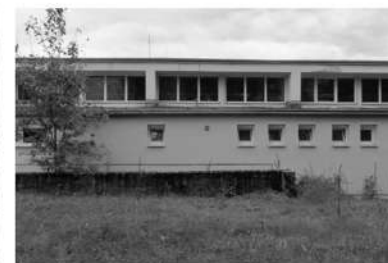
14. PRÍSTAVBA K VÝROBNEJ HALE - CHODBA Murovaný objekt 2. polovica 20. stor. Nevhodné doplnenie k existujúcemu objektu. Možné odstránenie.
