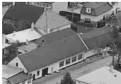
2. OBCHODNÁ PREVÁDZKA 2 Murovaná stavba 1. polovica 20. stor., bez viditeľného poškodenia. Prístavba k rodinnému domu. Možné zachovanie.
