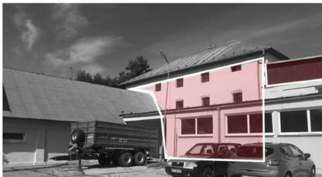
ÚPRAVA FASÁDY A PRINAVRÁTENIE POVODNÉHO VHĽADU
