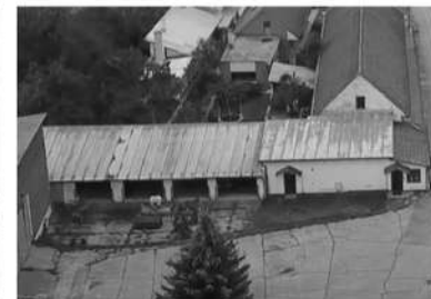
4. TECHNICKÉ SLUŽBY - KONTAJNÉRY Murovaná stavba 2. polovica 20. stor., chýbajúce dverné výplne. Prístavba k vrátnici. Možné odstránenie objektu.
