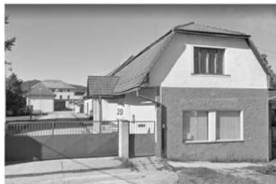
1. OBCHODNÁ PREVÁDZKA Murovaná stavba, 1. polovica 20. stor., bez viditeľného poškodenia. Vzhľad rodinného domu. Možné zachovanie.
