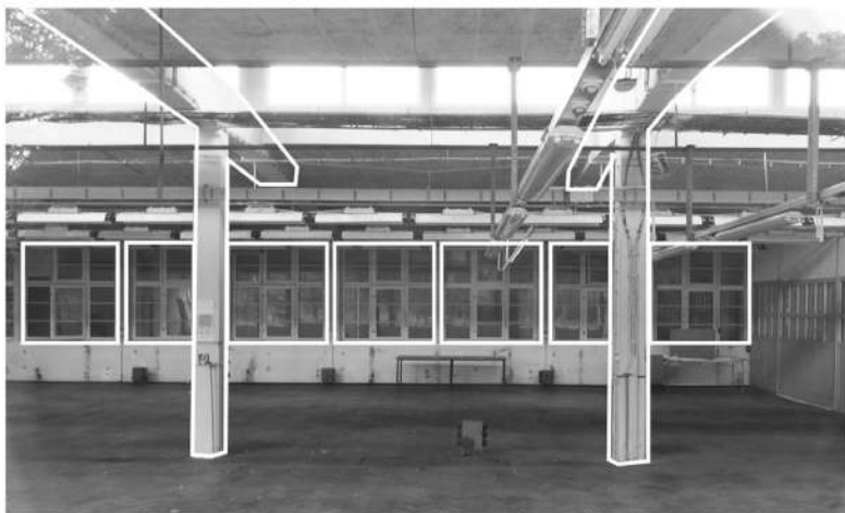
NOSNÁ KONŠTRUKCIA V PRIESTOROCH VÝROBNÝCH HÁL, PRIESTOR CELKOVÝ
