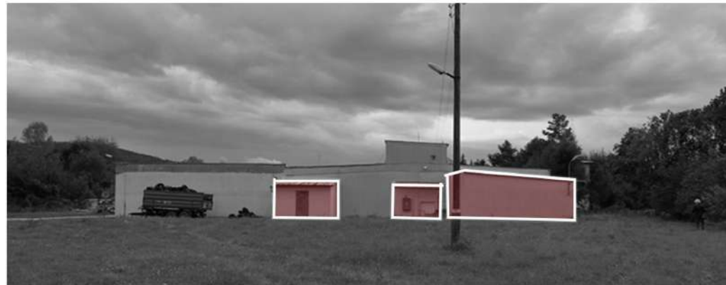
ODSTRÁNENIE RUŠIVEJ PRÍSTAVBY, ODKRYTIE POVODNEJ FASÁDY A JEJ OTVORENIE DO PRIESTORU
