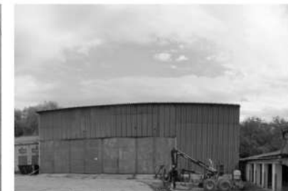
5. TECHNICKÉ SLUŽBY - GARÁŽ Kovová konštrukcia s plechovými obvodovými stenami, 2. pol. 20. stor. Možné odstránenie objektu.
