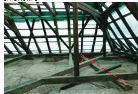
južné ukončenie krovu východného kridla
