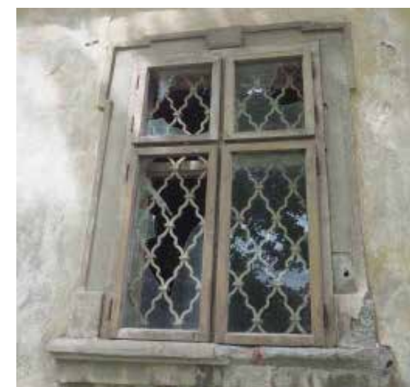
V3 // kovaná prevliekaná okenná mreža (neskorý barok - 2. 1/3 18.st.) K4 // okenné šambrány s ušnicou a lištovou profiláciou (neskorý barok - 1/3 18.st.)
