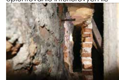
plenta prikotvená vmurovanými ocelovými tržmi
