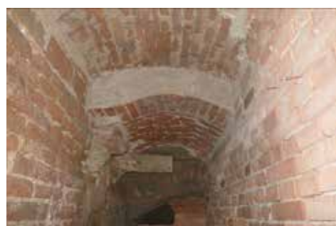
priestor po bývalom schodisku
