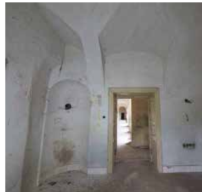
M10 // oválny klenutý výklenok pre kachľovú pec (neskorý barok - 2. 1/3 18.st.)
