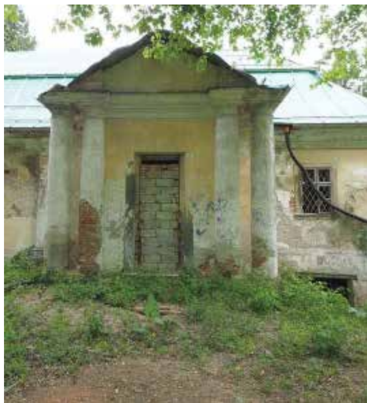
M3 // murivo z pálených značkových tehál na vápenno-pieskovú jemnozrnnú maltu (klasicizmus - 3. 1/3 18.st.) M12 // portikus (empír- 1. 1/2 19.st.) K3 // obdĺžnikový kamenný portál s hladkým ostentím (neskorý barok - 2. 1/3 18.st.)
