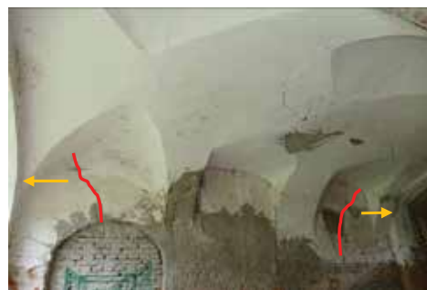
štitová stena S krídla, pohľad z interiéru
