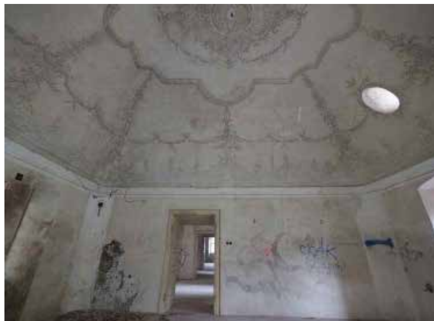
M4 // valené výsečové, korýtková, valná klenba (neskorý barok - 2. 1/3 18.st.)
