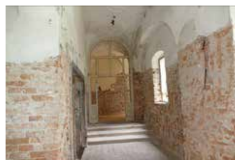
arkádová chodba, severné krídlo
