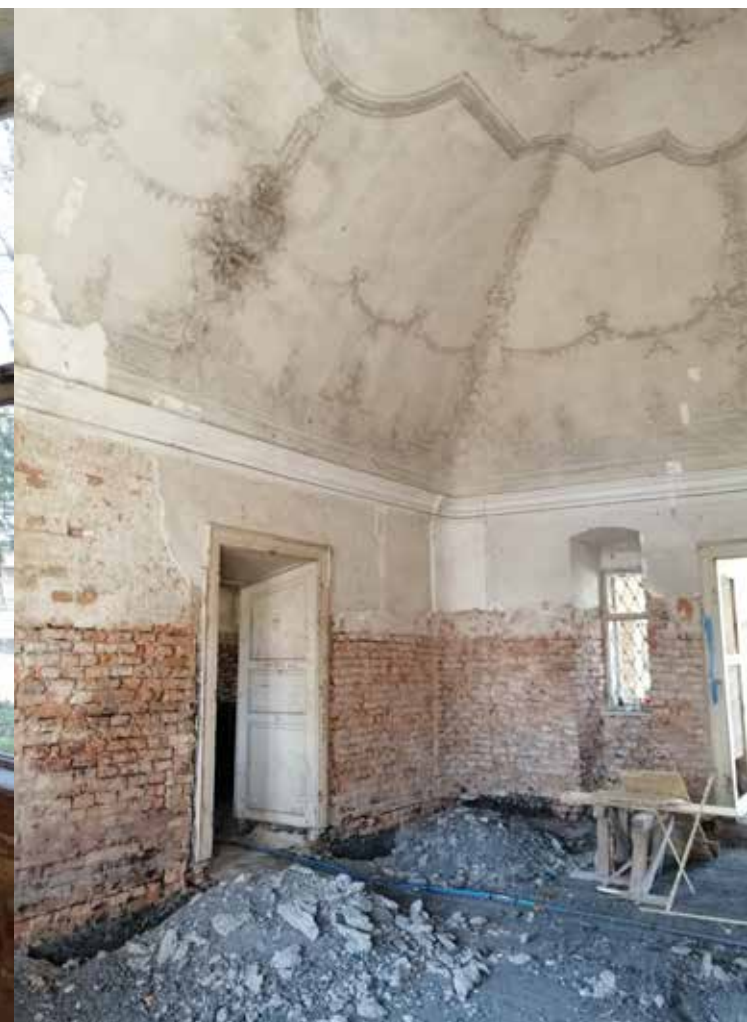
veľký salón veľký salón - hlavná sála, pohľad na vytrhanú podlahu, výšku priestoru a klenbu
