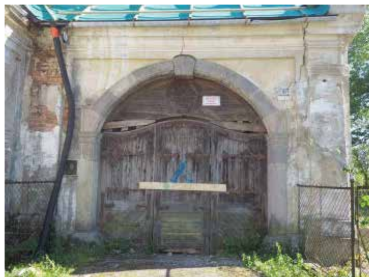
K1 // Kamenný polkruhový portál s profilovaným ostentím, vrcholovým erbovým klenákom a okopníkmi (neskorý barok, 2. 1/3 18.st.) D3 // trojdielna otvárací brána s dekoratívnou pevnou supraportou (neskorý barok, 2. 1/3 18.st.)
