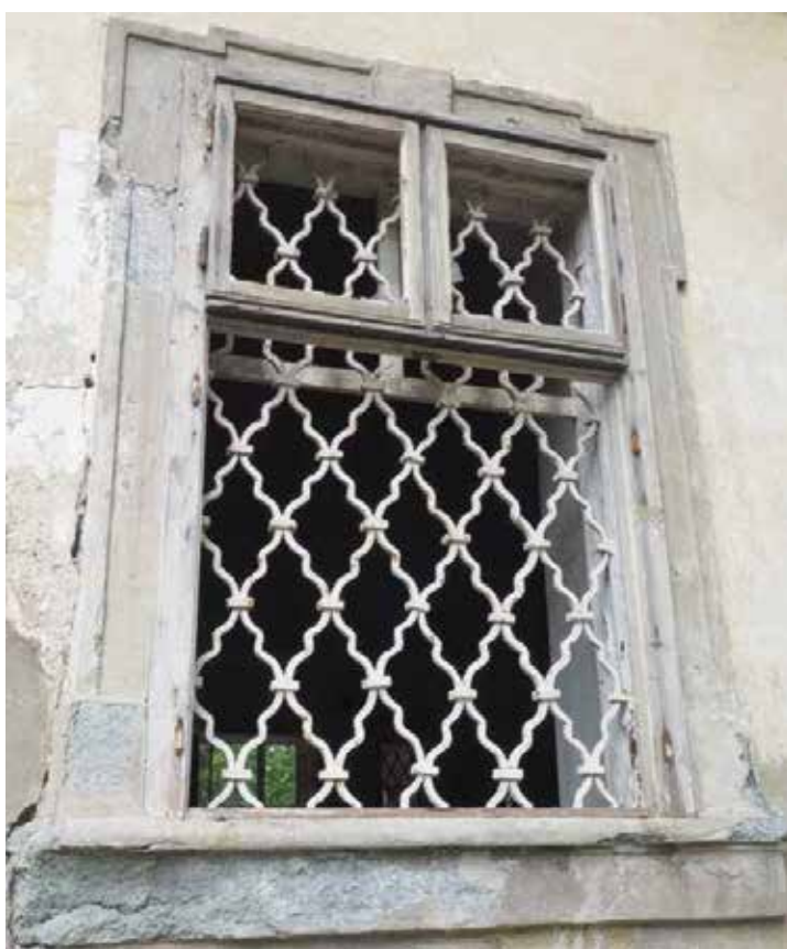
V3 // kovaná prevliekaná okenná mreža (neskorý barok - 2. 1/3 18.st.) K4 // okenné šambrány s ušnica a lištovou profiláciou (neskorý barok - 1/3 18.st.)
