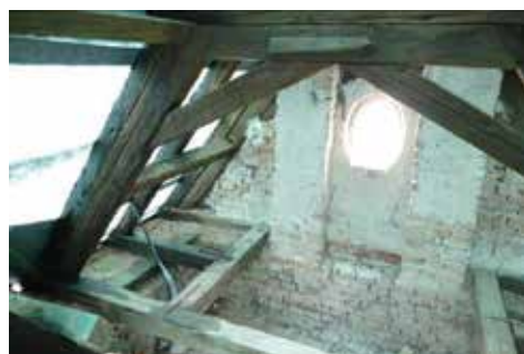
krov severného rizalitu
