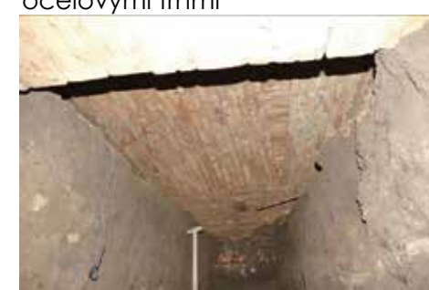
novodobá klenba + zasypaný
