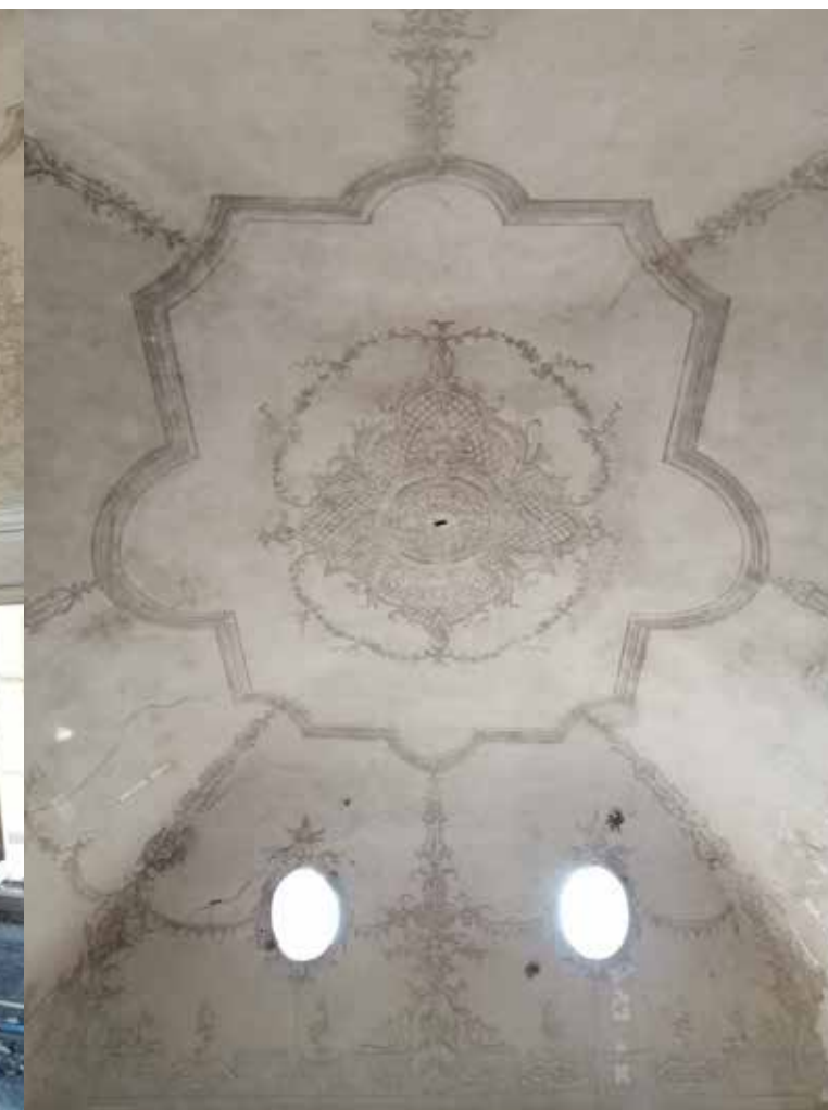
klenba klenba v hlavnej sále, viditeľná výmalba, svetlovody z východného štítu
