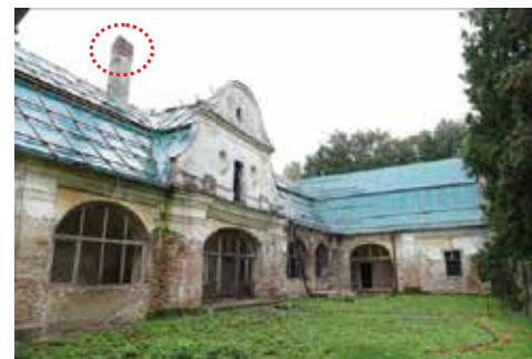
zatekaním zrážkovej vody cez poškodenú krytinu
