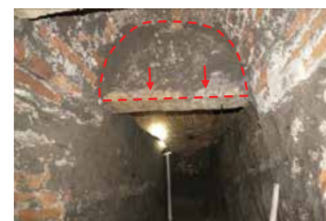
pôvodný vstup do suterénu
