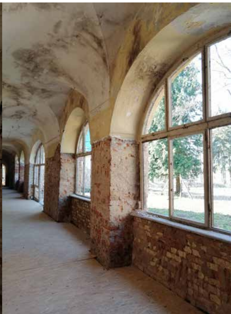
arkáda baroková arkáda bola pôvodne otvorená, v klasicizme tu vymurovali parapety a vytvorili okná
