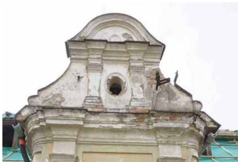
M16 // strešný štít (neskorý barok - 2. 1/3 18.st.) O3 // omietková výzdoba pilastrov a ríms (neskorý barok - 1/3 18.st.)
