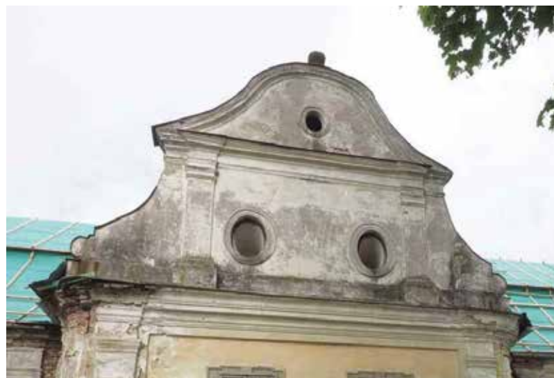
M16 // strešný štít (neskorý barok - 2. 1/3 18.st.) O1 // hladená omietka (neskorý barok - 1/3 18.st.) O3 // omietková výzdoba pilastrov a ríms (neskorý barok - 1/3 18.st.)
