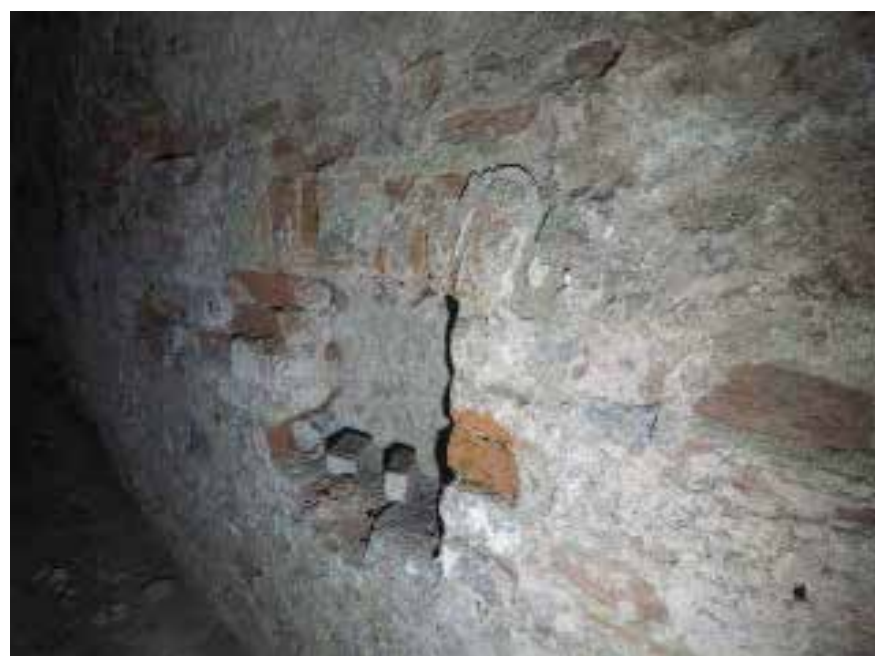
M6 // stenová nika pre svetidlo, segmentovo zaklenutá (neskorý barok - 2. 1/3 18.st.)
