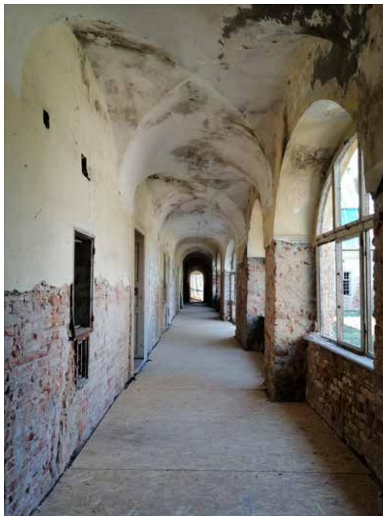
chodba pohľad na arkádovú chodbu
