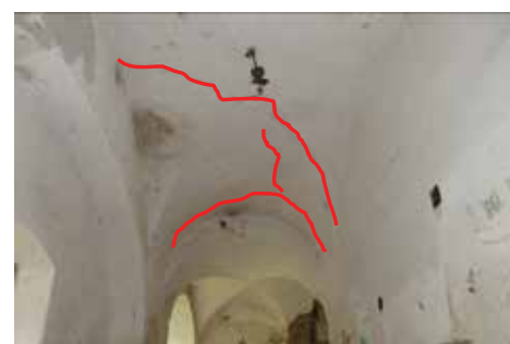
arkádová chodba severné krídlo
