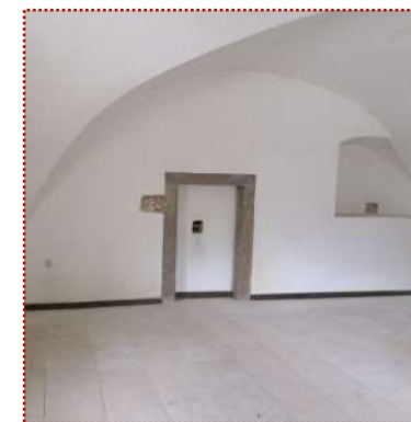
Zamurovaný renesančný kamenný portál
