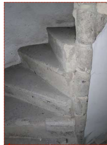
Renesančne kamenné schodisko datované do druhej tretiny 17.stor.
