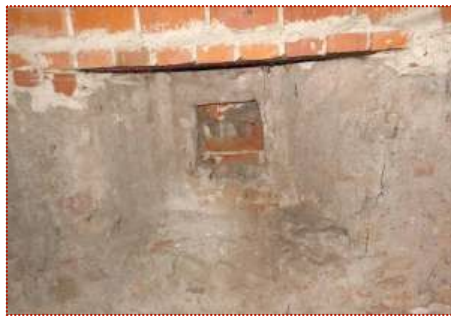
Krov - Strielne renesancia 1586 - zachovaná v autentickom stave z exteriéru zamurovaná nachádzajúce sa zna SV rizalite objektu
