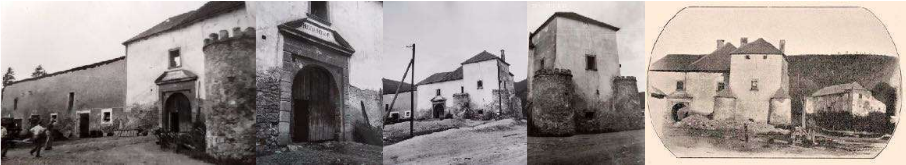
Vonkajšie zabery na kaštieľ, hľavný vstup do kaštieľa, dnes už zaniknute bašty s kruhovým pôdorysom
