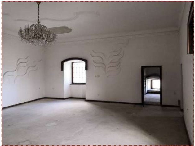
Štuková výzdoba stropu kópia z poslednej obnovy z 80.rokov 20.stor.
