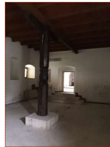
Drevený trámový strop - kópia renesančného stropu datovaného do roku 1586 z poslednej obnovy
