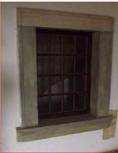
Jediná pôvodná okenná šambrána v objekte 17.storočia
