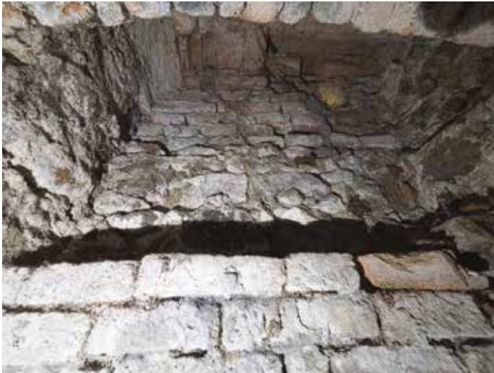
M5 // VETRACÍ PIVNIČNÝ OTVOR (NEKORÝ BAROK - 2. 1/3 18.ST.)
