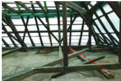
južné ukončenie krovu východného krídla
