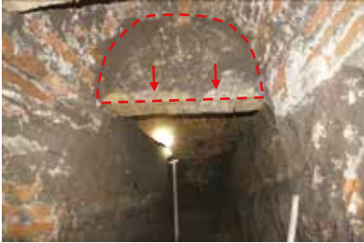
pôvodný vstup do suterénu
