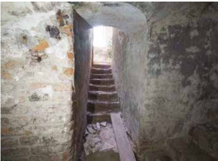
M7 // JEDNORAMENNÉ TEHLOVÉ SCHODISKO (NESKORÝ BAROK - 2. 1/3 18.ST.)
