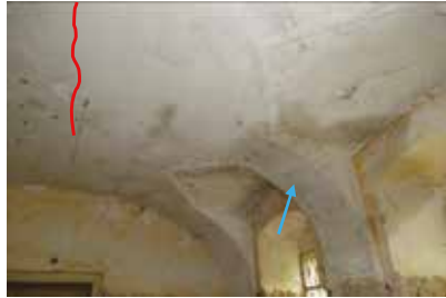
premokrená klenba trhliny
