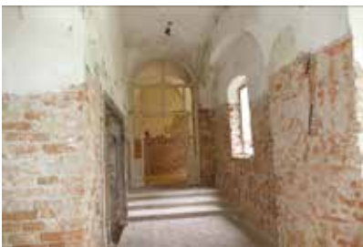
arkádová chodba, severné krídlo
