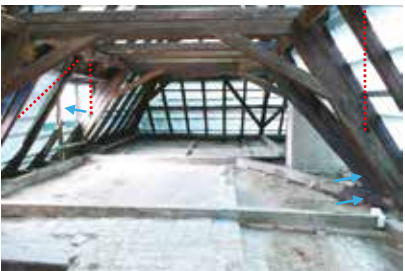
chýbajúce vzpery v strešnej rovine
