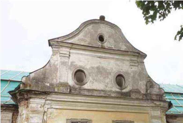
M16 // STREŠNÝ ŠTÍT (NEKORÝ BAROK - 2. 1/3 18.ST.) O1 // HLADENÁ OMIETKA (NEKORÝ BAROK - 1/3 18.ST.) O3 // OMIETKOVÁ VÝZDOBA PILASTROV A RÍMS (NEKORÝ BAROK - 1/3 18.ST.)
