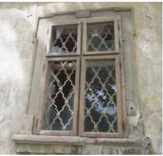
V5// PÁNTY A ZÁVESY KRÍDEL BRÁNY A INTERIÉROVÝCH DVERÍ (POLOVICA 20.ST.)V3 // KOVANÁ PREVLEIKANÁ OKENNÁ MREŽA (NESKORÝ BAROK - 2. 1/3 18.ST.)
