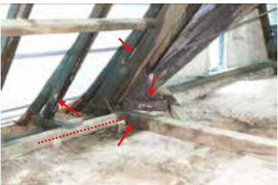
Poškodené prvky pri centrálnom dvor.štíte
