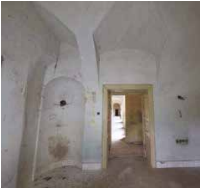
M10 // OVÁLNY KLENUTÝ VÝKLENOK PRE KACHLOVÚ PEC (NESKORÝ BAROK - 2. 1/3 18.ST.)
