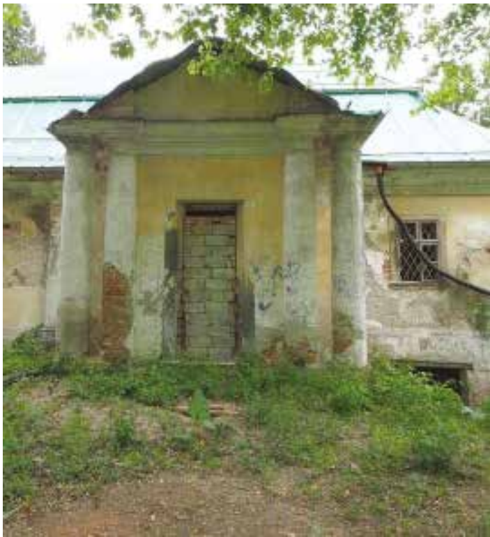
M3 // MURIVO Z PÁLENÝCH ZNAČKOVANÝCH TEHÁL NA VÁPENNO-PIESKOVÚ JEMNOZRNNÚ MALTU (KLASICIZMUS - 3. 1/3 18.ST.)
