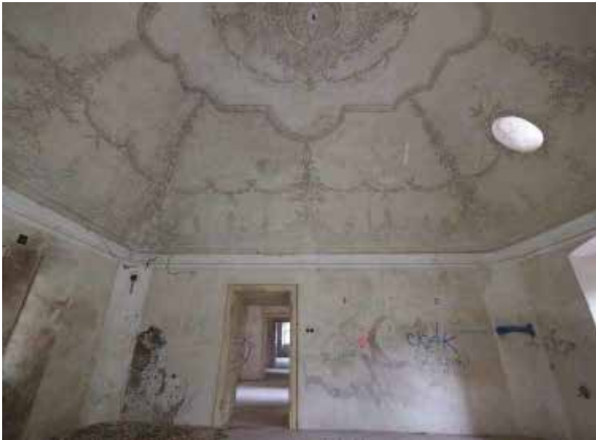
M4 // VALENÉ VÝSEČOVÉ, KORÝTKOVÁ, VALNÁ KLENBA (NESKORÝ BAROK - 2. 1/3 18.ST.) L1 // ORNAMENTÁLNA MAĽOVANÁ VÝZDOBA KLENIB (19.ST.)
