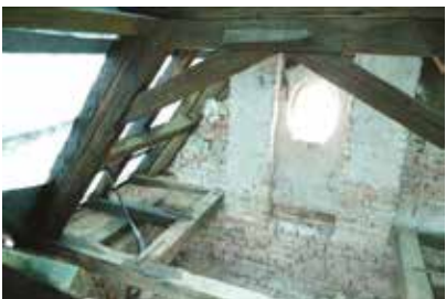
krov severného rizalitu
