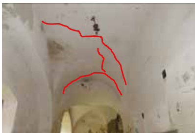
arkádová chodba severné krídlo
