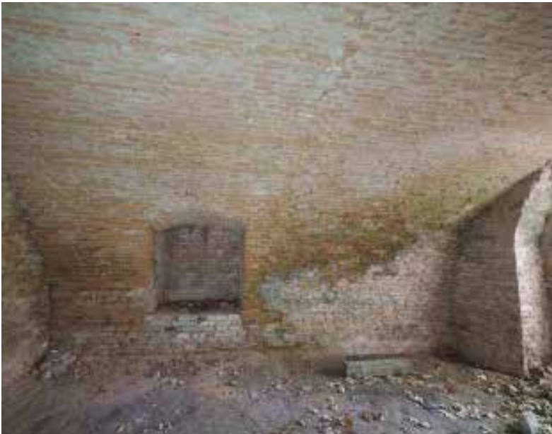
M2 // MURIVO Z PÁLENÝCH ZNAČKOVANÝCH TEHÁL NA VÁPENNO-PIESKOVÚJEMNOZRNNÚ MALTU (NESKORÝ BAROK - 2. 1/3 18.ST.)
