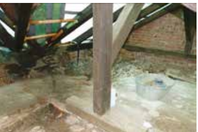
krov južného rizalitu
