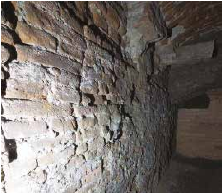
M8 // ZANIKNUTÉ JEDNORAMENNÉ SCHODISKO NA 1.NP (NESKORÝ BAROK - 2. 1/3 18.ST.)
