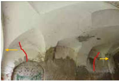
štítová stena S krídla, pohľad z interiéru
