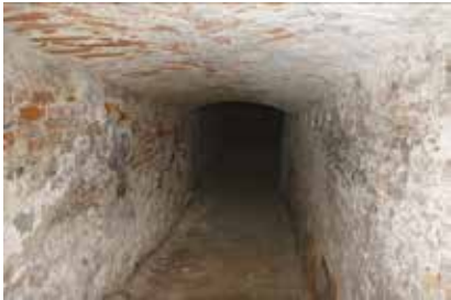
vstup do severnej časti suterénu
