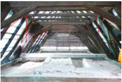
chýbajúce vzpery v strešnej rovine
