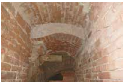
priestor po bývalom schodisku
