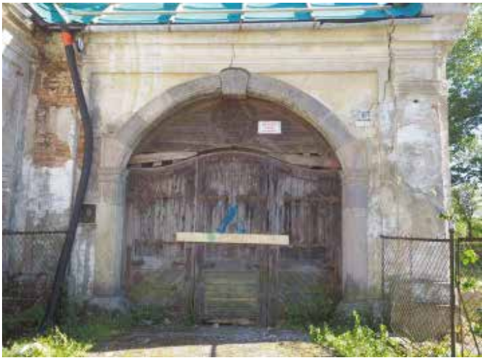
K1 // KAMENNÝ POLKRUHOVÝ PORTÁL S PROFILOVANÝM OSTENÍM, VRCHOLOVÝM ERBOVÝM KLENÁKOM A OKOPNÍKMI (NESKORÝ BAROK, 2. 1/3 18.ST.) D3 // TROJDIELNA OTVÁRAVÁ BRÁNA S DEKOROVANOU PEVNOU SUPRAPORTOU (NESKORÝ BAROK, 2. 1/3 18.ST.)
