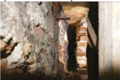
plenta prikotvená vmurovanými oceľovými tržmi
