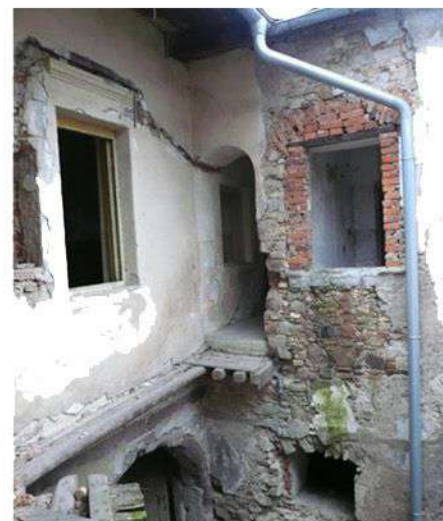
Chýbajúca pavlač a viditeľné opotrebovanie omietok
