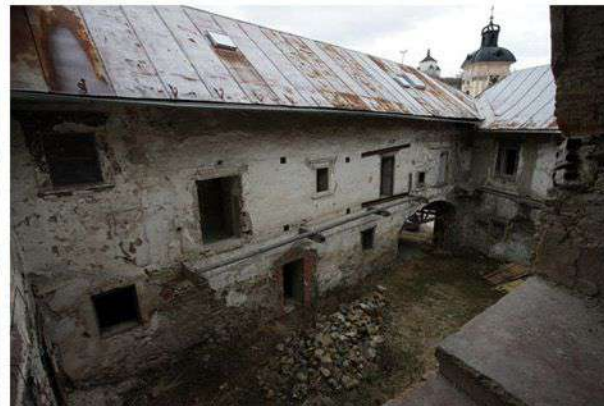
Pohľad na severo-západnú fasádu nádvorja
