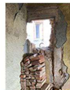
Kamenný portál (čiastočne odkrytý) 2. polovica 16. storočia
