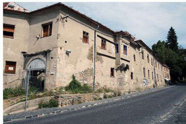
Pohľad na východnú fasádu
