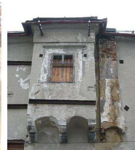
Chýbajúce komínové telesá, zdobenie a rímsovanie
