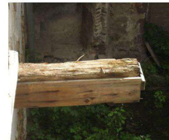
Opotrebovanie drevených trámov ktoré podopierali pavlač.
