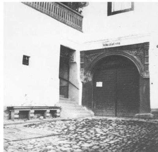
Pohľad na juho-východnú fasádu nádvorja
