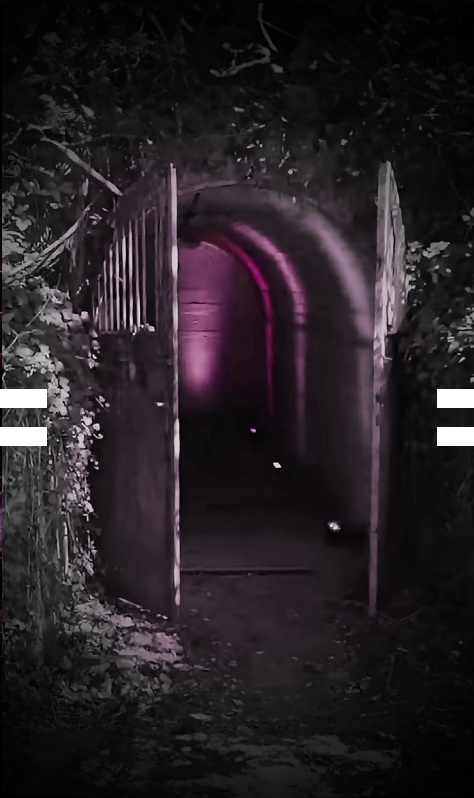
Bratislava Železná Studnička
